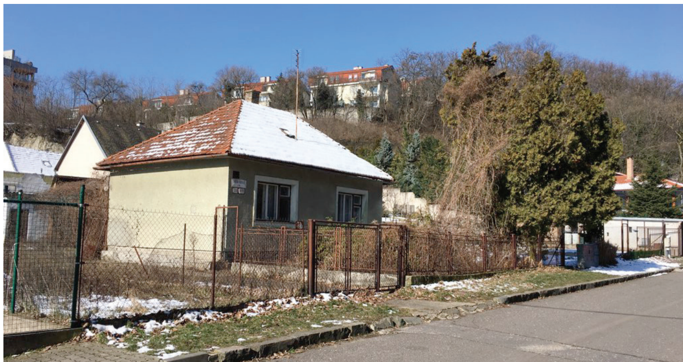
Aj na mieste tohto rodinného domu na začiatku Liščieho údolia plánujú výstavbu bytového domu.
